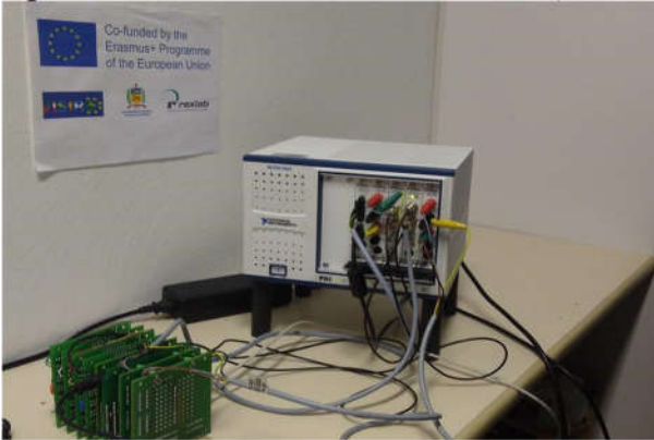
Figura 12 – Módulo VISIR instalado no RExLab (UFSC – Araranguá)
