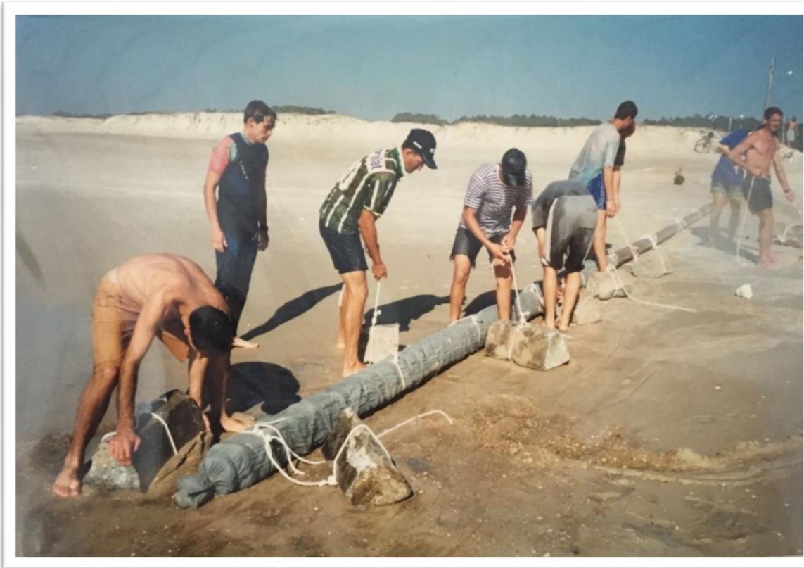
Substituição de ponteiros do sistema de captação de água marinha da EMEB
