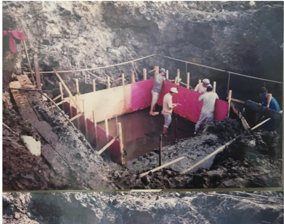
Construção de sistema de bombeamento
