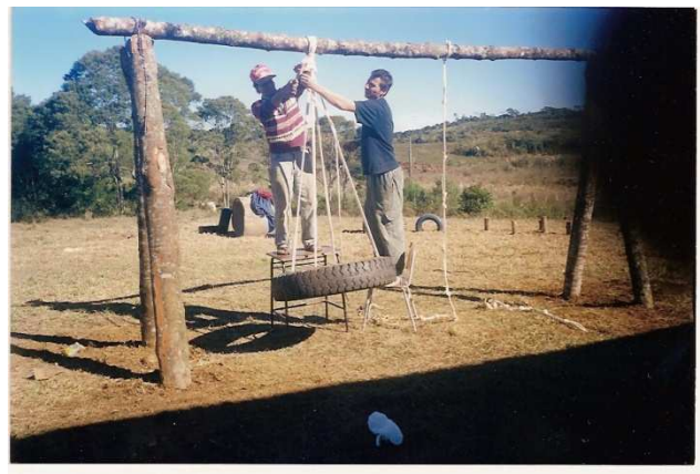
Figura 9: Construção de balanço.
