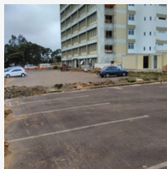
Ilustra a execução das escavações previstas no trecho Y do projeto;
