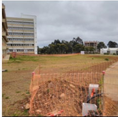
Ilustra reaterro de valas no trecho B e C do projeto de Iluminação externa;
