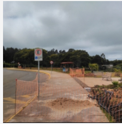
Ilustra reaterro de valas no trecho H e N do projeto de Iluminação externa;
