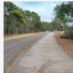
Ilustra término do trecho N com o reaterro de valas e execução das caixas de passagens;
