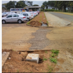
Idem fotografia 4 de outro ângulo ilustrando o reaterro e corte no pavimento asfáltico;
