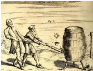
Figura 12 - Experimento com um barril de madeira em uma tentativa de se produzir um vácuo. Fonte: GUERICKE (1672, p. 74).
