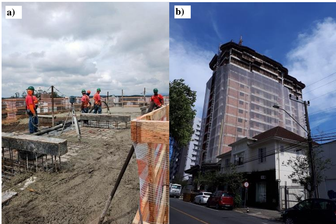
Figura 10 - a) concretagem tipo 14. b) vista frontal da obra.
