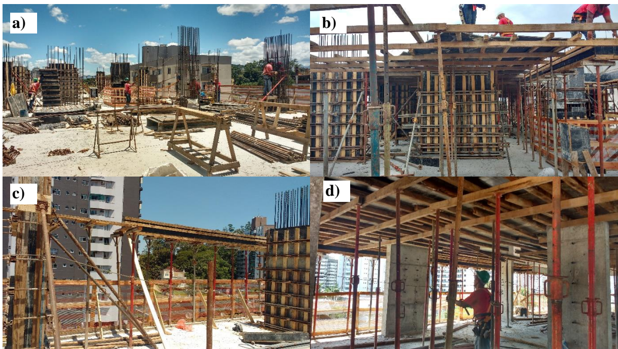
Figura 8 - a) montagem de pilares e formas de pilares. b) assoalhamento da laje. c) colocação de formas de vigas externas. d) escoramento da laje.
