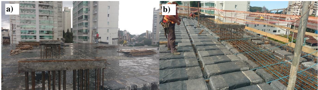
Figura 9 - a) assoalho da laje concluído. b) laje com as armaduras.
