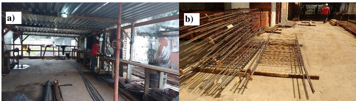
Figura 7 - a) corte e dobra armação. b) pilares prontos para içamento.
