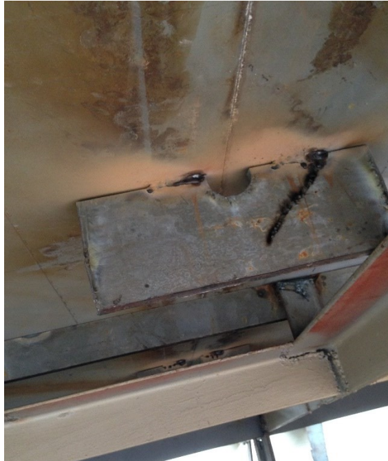
Figura 55 Pontes soldadas sob as chapas a serem unidas
