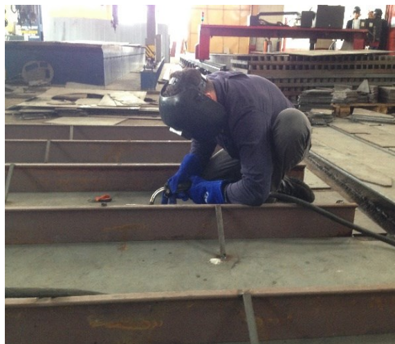
Figura 41 Apoios para soldagem de reforços
