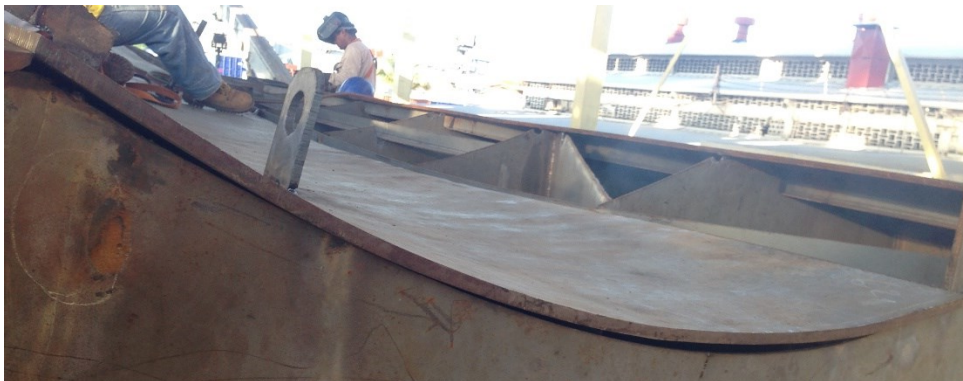
Figura 36 Chapa conformada já posicionada no bloco
