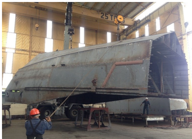
Figura 16 Movimentação de um bloco (bloco anel invertido)
