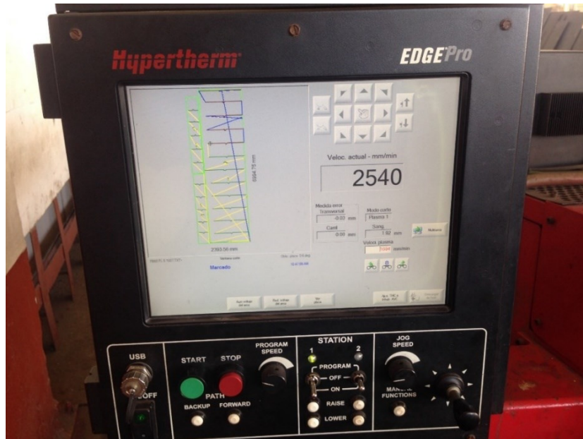
Figura 22 Central de controle
