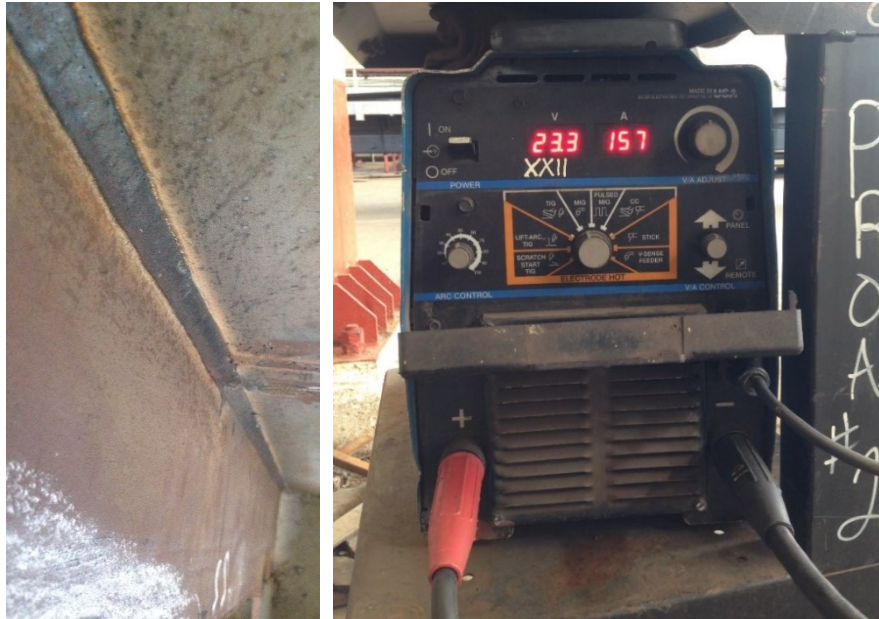
Figura 45 Resultado do cordão e a fonte de soldagem utilizada para soldar aço
