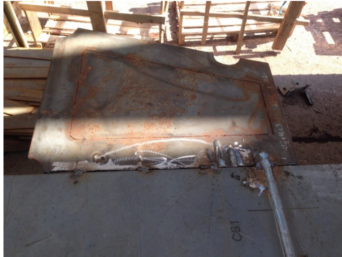
Figura 49 Placa soldada provisoriamente
