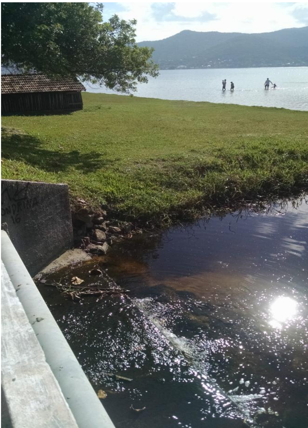
Figura 42 - Sistema ambiental canais de drenagem da Lagoa da Conceição. Fonte: Foto do autor.
