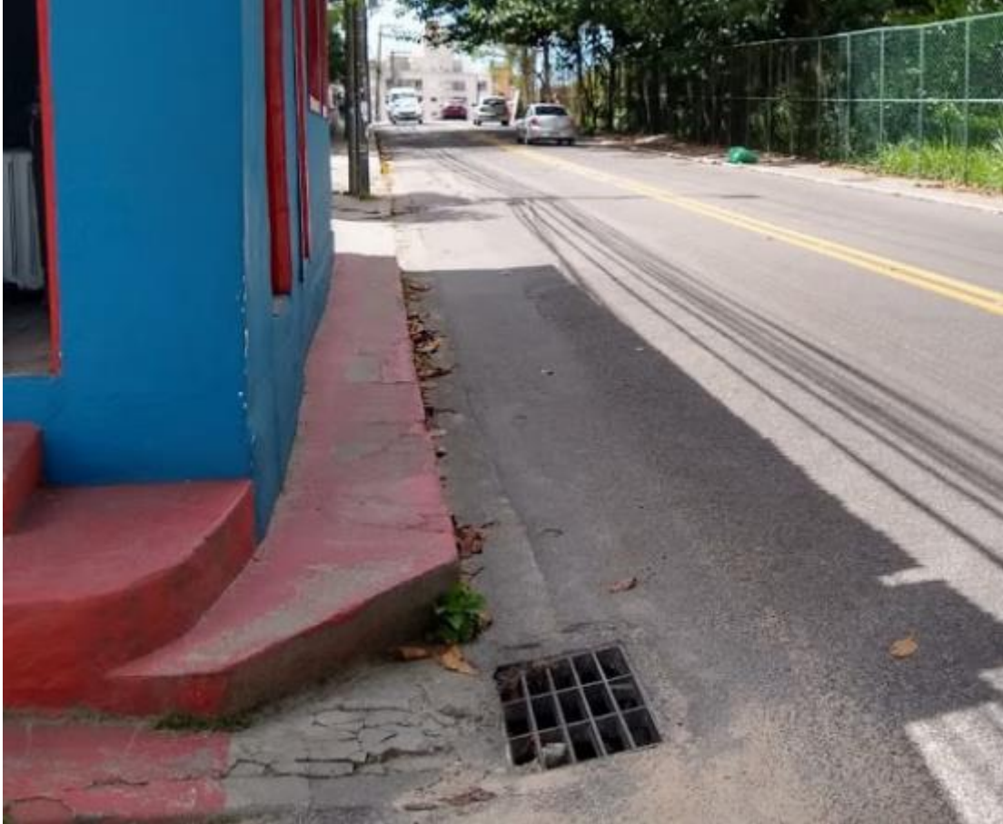
Figura 30 Rua Lauro Linhares, detalhe à calçada diminuta, sem rampa de acesso ou piso tátil.
