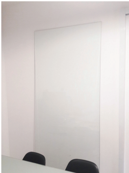
Figura 34 - Parede para aplicação
