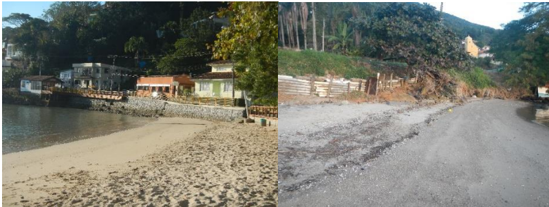
Figura 48: à esquerda, muro de arrimo, Praia da Barra do Sambaqui; à direita, muro de arrimo, Ribeirão da Ilha.
