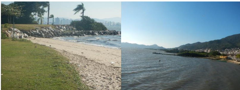
Figura 49: à esquerda, estrutura de enrocamento, Centro; à direita, estruturas de espigões, Aterro da Baía Sul.
