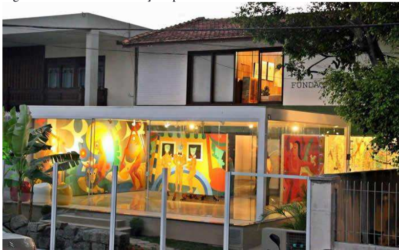
Figura 3 – Fachada da Fundação após as reformas
