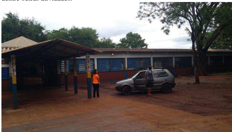
Figura 10. Fachada do prédio da entrada.
