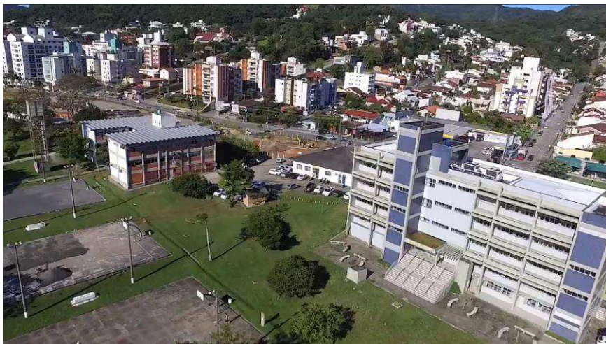
Figura 8 - Prédios do CDS
