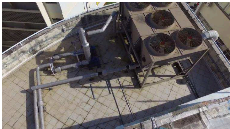
Figura 15 - Estruturas sobre a cobertura do prédio
