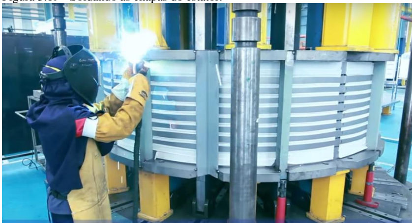
Figura 5.19 - Soldando as chapas do estator.
