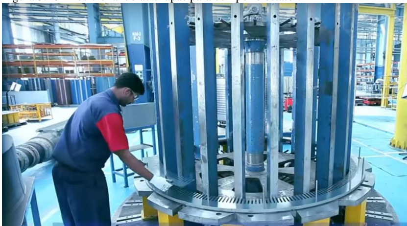
Figura 5.18 - Posicionando as chapas para compor o estator.
