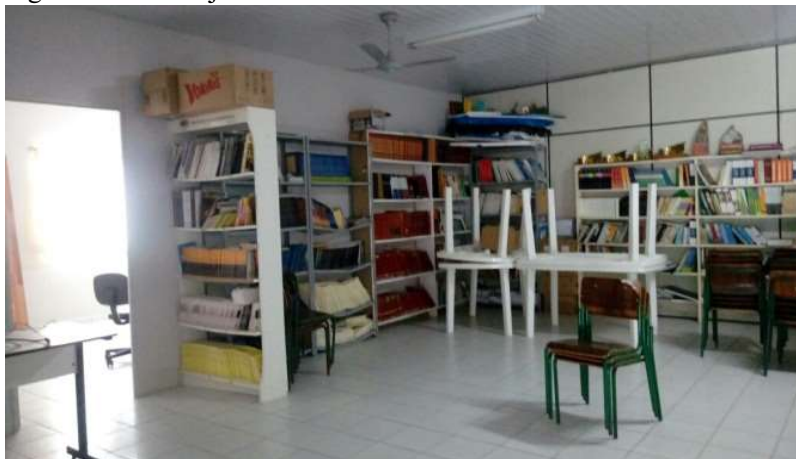
Figura 2: Falta de janelas no interior da biblioteca.
