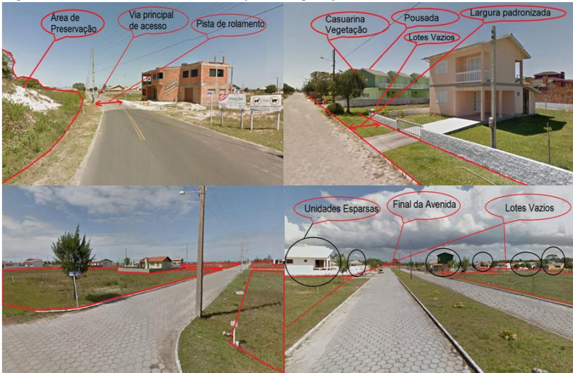
Figura 86 - Vista das ruas, edificações, vegetação e vazios
