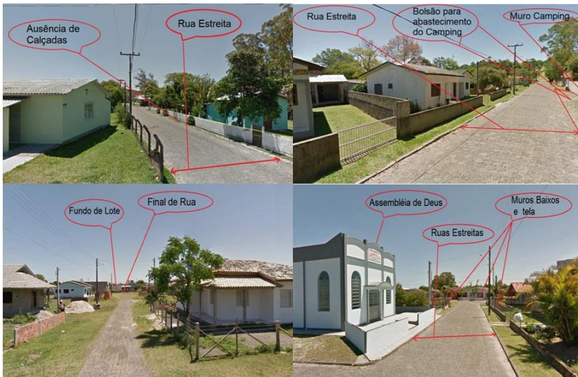
Figura 66 - Vista parcial das ruas estreitas, passeios, muros e relações Rua X Lotes
