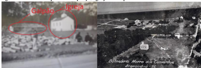
Figura 33 - A Vista parcial da praça, Igreja e Galpão de Madeira
