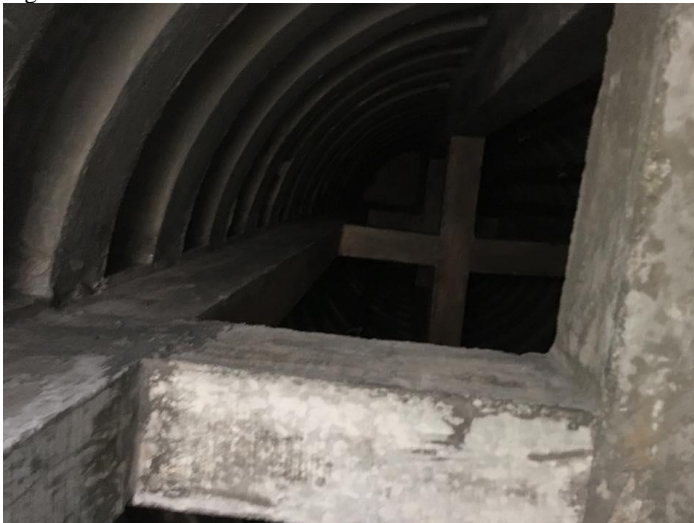
Figura 23 - Estrutura interna da torre de abastecimento
