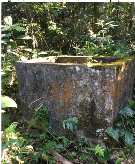
Figura 32 - Estrutura de concreto do poço tubular
