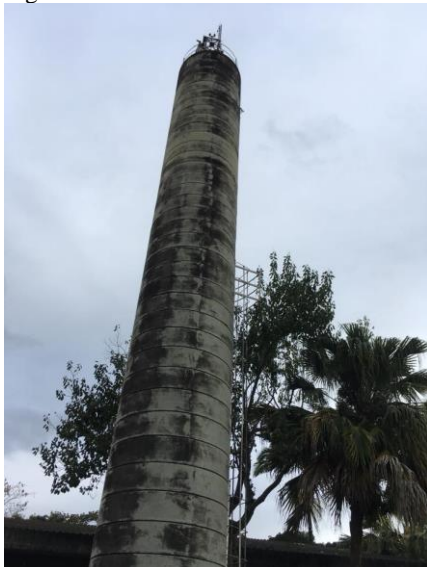
Figura 22 - Torre de abastecimento da RMSC
