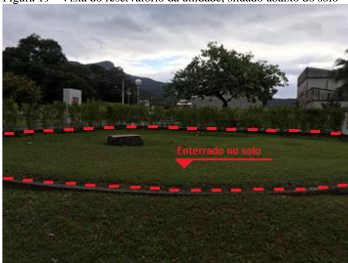
Figura 19 - Vista do reservatório da unidade, situado abaixo do solo
