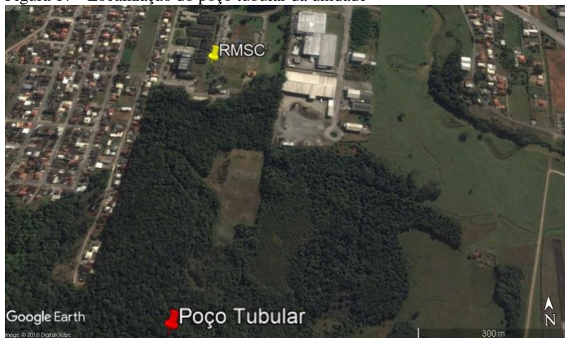
Figura 17 - Localização do poço tubular da unidade
