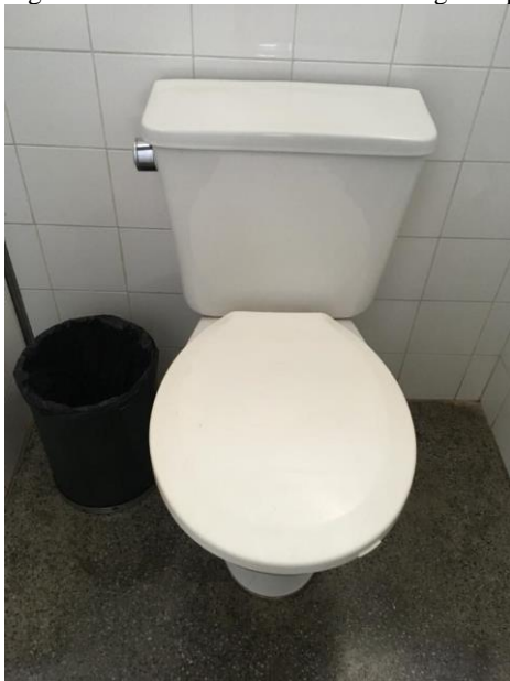
Figura 24 - Bacia sanitária com descarga acoplada
