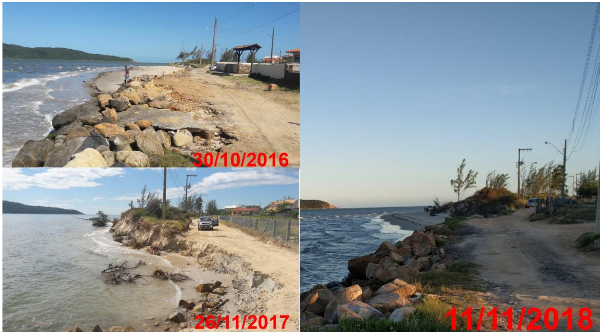
Figura 11 - Recorte atual de parte do trecho norte, onde em 1996 foi realizada a obra de recuperação.
