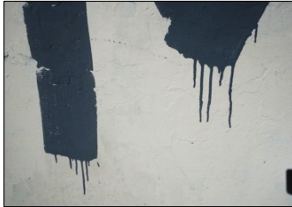
Figura 50 – Muro no Centro de Florianópolis.
