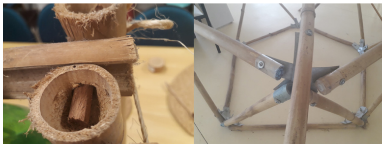
Figura 14: Ligação entre peças de bambu com tarugos de madeira de Lluvia Perdomo e Ligação parafusada com apoio de chapas metálicas em geodésica de Sumara Lisboa - Grupo de pesquisa Virtuhab. Foto: Librelotto (2019).
