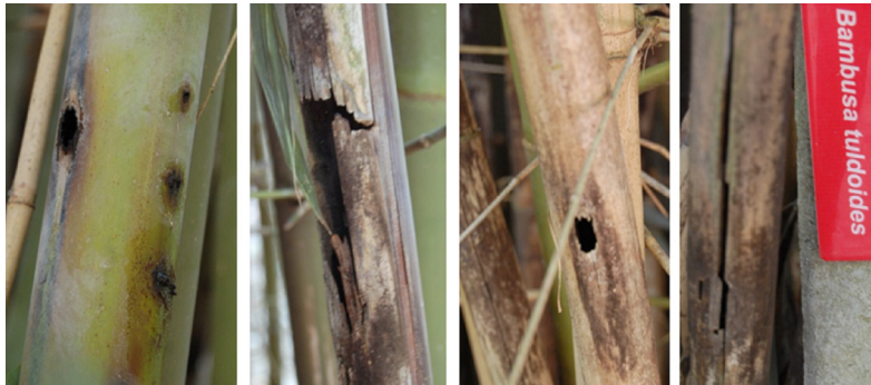
Figura 06: Furos, apodrecimento e morte dos colmos de B. tuldooides . Fotos: J.P.S. Ostapiv.
