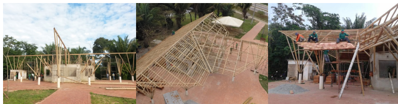
Figura 12: Estrutura do quiosque. Fonte: Carolina Sgorla, 2018.
