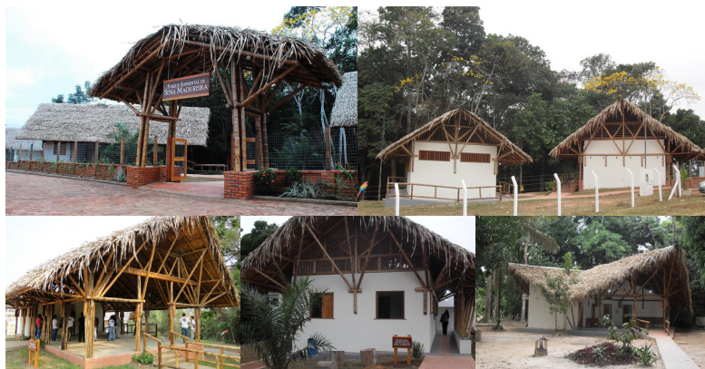
Figura 06: Edificações no Parque Ambiental Padre Paolino Baldazari non Acre. Fonte: Celina Llerena, 2018.
