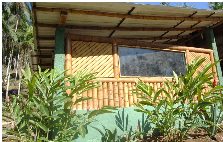
Figura 22: Peças de G. angustifolia usadas na parede e no telhado de pousada, Paraty – RJ. Foto: Ostapiv (2016)
