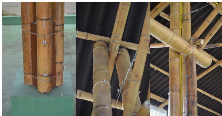
Figura 30: Detalhes construtivos. Fonte: Andrea Jaramillo, 2018.
