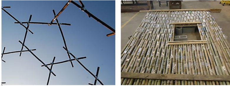
Figura 13 – Colmos de B. tuldooides em geodésica e em parede pré-fabricada com embalagens PET. Fotos: Ostapiv (2018 e 2016)
