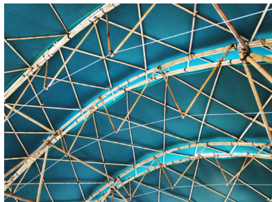
Figura 22: Estrutura de bambu na cúpula do anfiteatro. Fonte: Bambutec, 2018.
