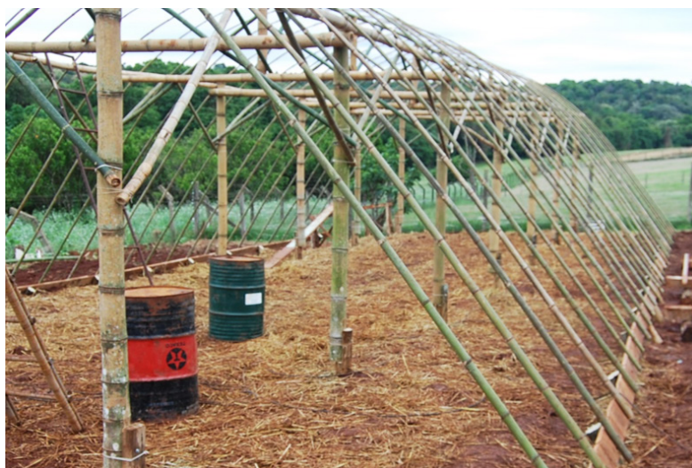
Figura 19: Arcos de P. aurea usados na construção de estufa CPRA no IAPAR-PB. Foto: Ostapiv (2016)
