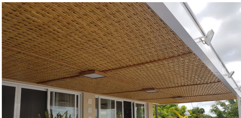
Figura 11: Foto forro em esteiras de bambu trançado utilizado em residência paulista. Foto: Pupo (2018).
