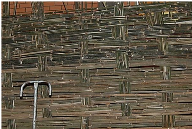
Figura 03: Pannel de taquara trançada, feito com vários colmos laminados de bambu M. skvortzovii . Foto: Ostapiv (2017)
