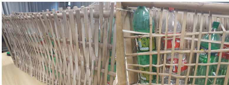
Figura 13: Painel PET-à-pique Lluvia Perdomo - Grupo de Pesquisa Virtuhab em duas faces com tramas e ligações encaixadas. Foto: Librelotto (2019).
