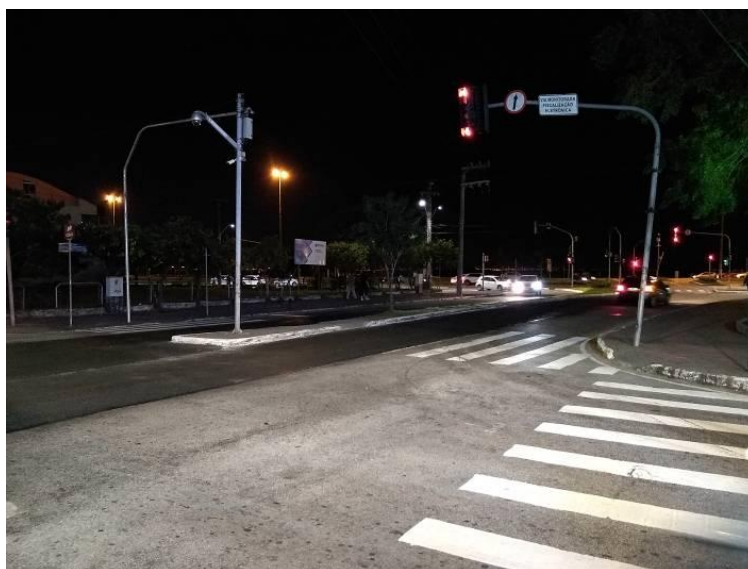
Figura 68 - Semáforo na esquina com Rua Bocaiúva e Rua Heitor Luz
