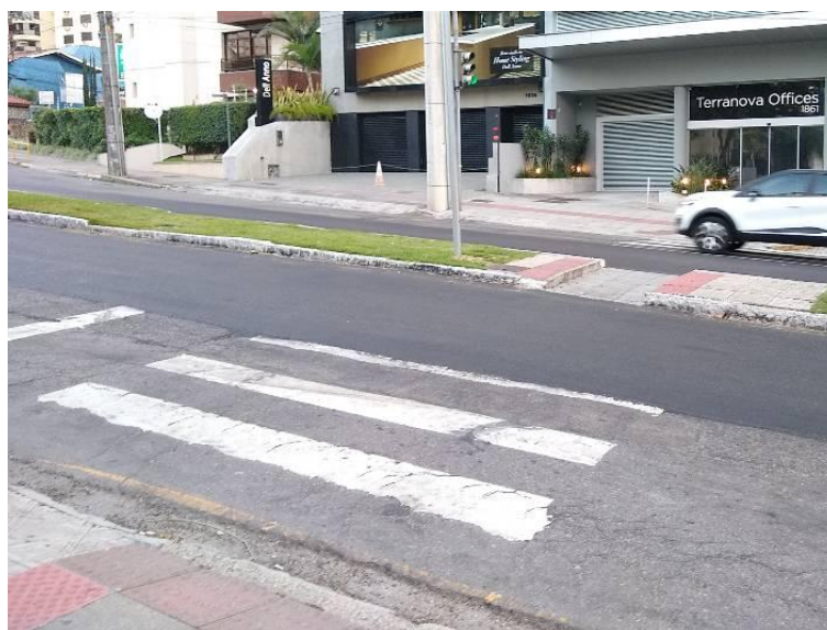
Figura 67 - Faixa de pedestres na esquina com Rua Demétrio Ribeiro
