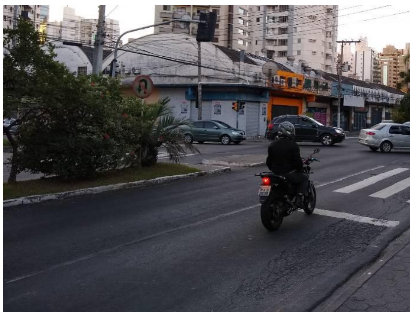
Figura 59 - Exemplo de sinalização vertical coberta pela vegetação
