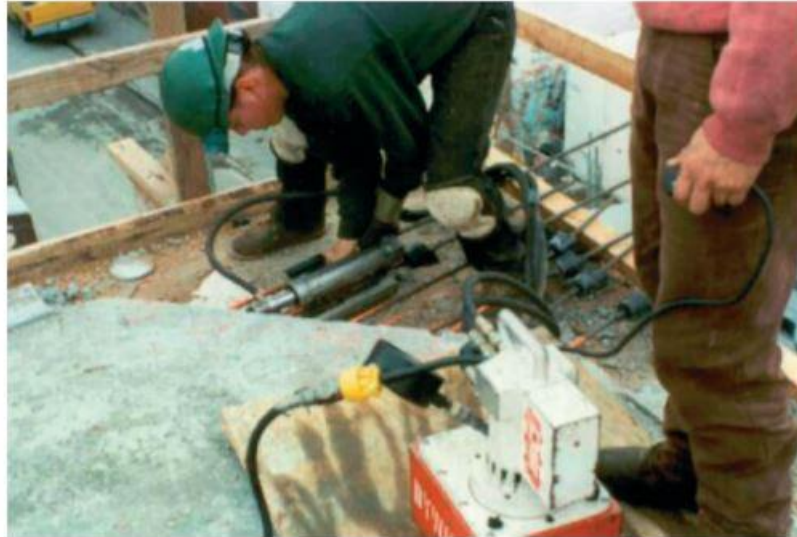
Figura 26 - Tensionamento da armadura de protensão com macaco hidráulico
