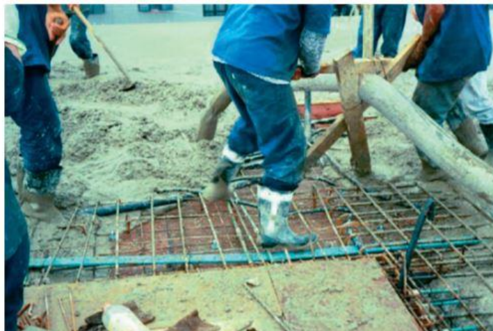
Figura 25 - Lançamento de concreto sobre as armaduras
