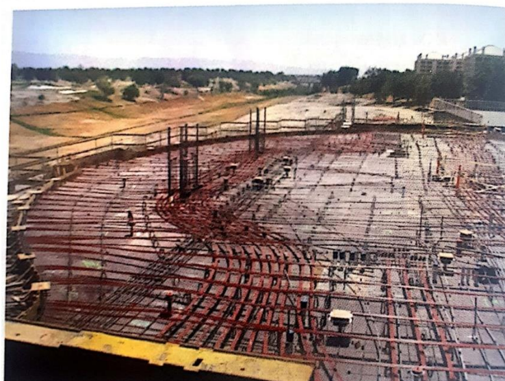
Figura 37 – Montagem dos cabos com apoios não alinhados
