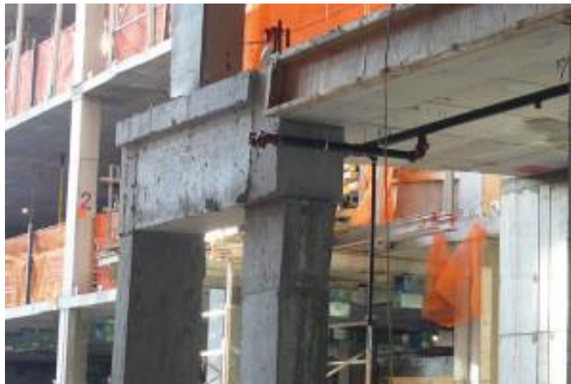
Figura 17 – Viga de transição
