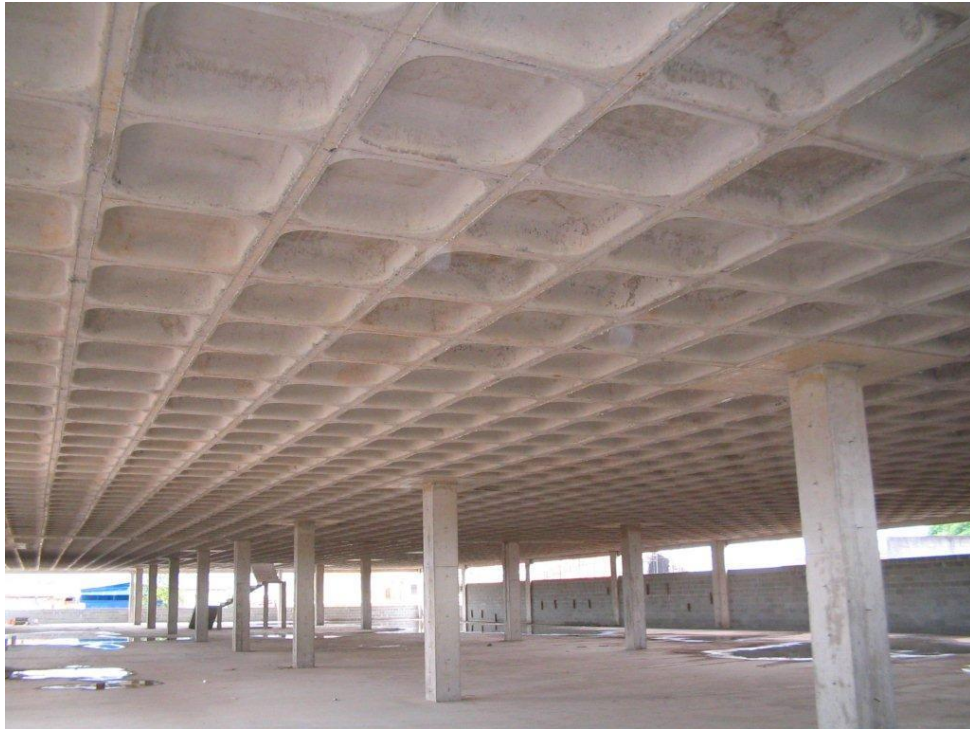
Figura 16 – Laje nervurada bidirecional com capitéis em concreto protendido
