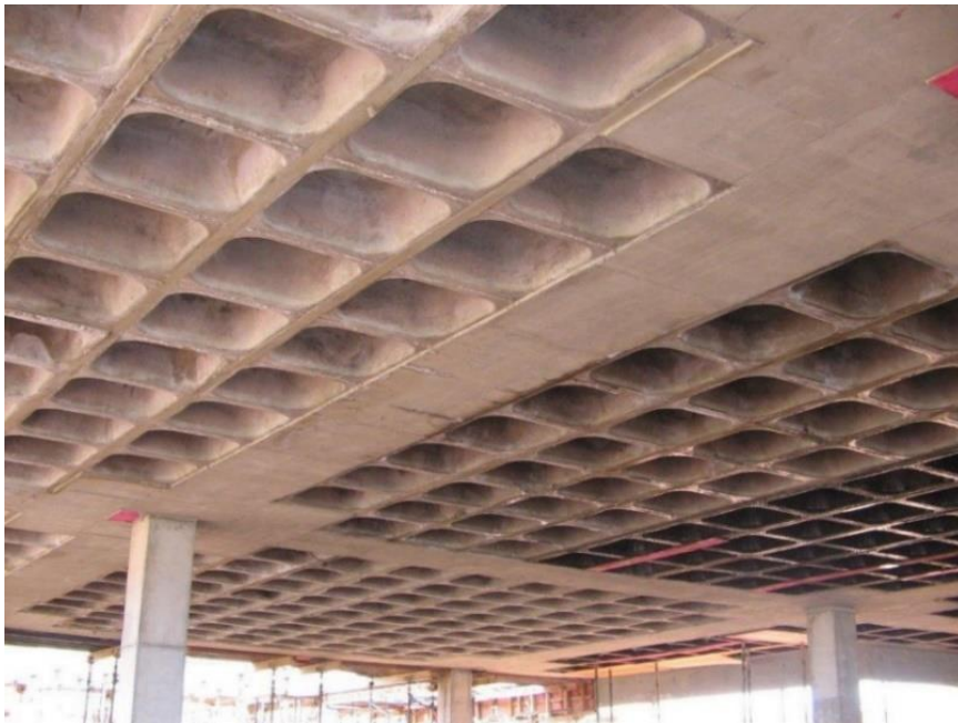
Figura 9 – Sistema estrutural de laje nervurada bidirecional e vigas-faixa em concreto protendido
