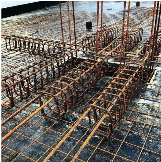
Figura 67 – Armadura de punção com estribos
