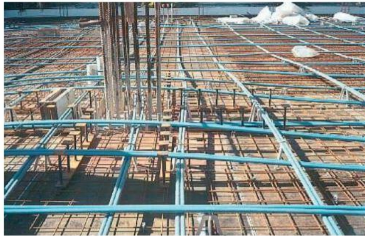
Figura 24 - Posicionamento de armadura ativa, passiva e fretagem
