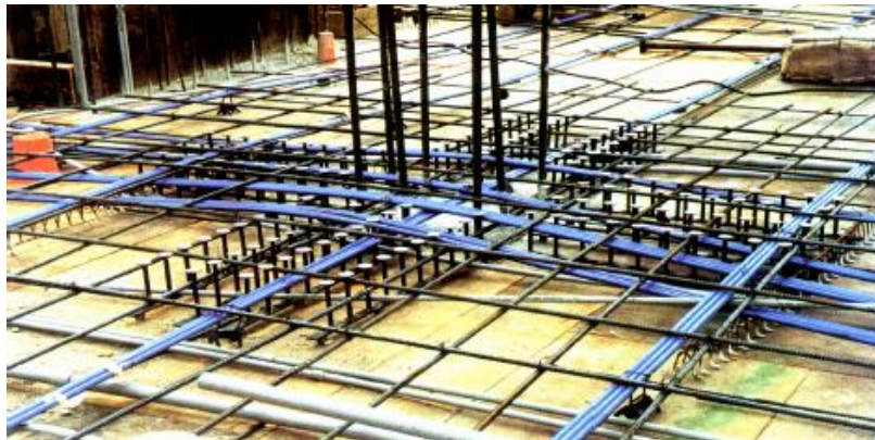
Figura 66 – Armadura de punção com conector tipo pino
