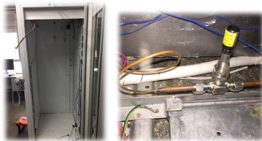
Figura 9 Substituição do dispositivo de expansão.
