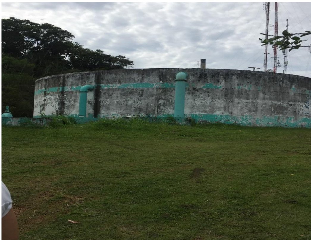
Figura 6 - Tanque do Reservatório Cachoeira de 1.000m 3 .
