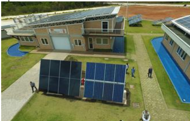
Figura 21 – Seguidor solar de um eixo, sendo que o sistema da direita é composto por módulos de silício cristalino multicristalino, que foram utilizados para o experimento.
