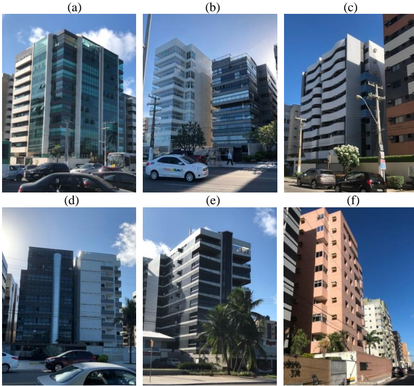
Figura 25: Imagens de fachadas de edifícios residenciais em Maceió
