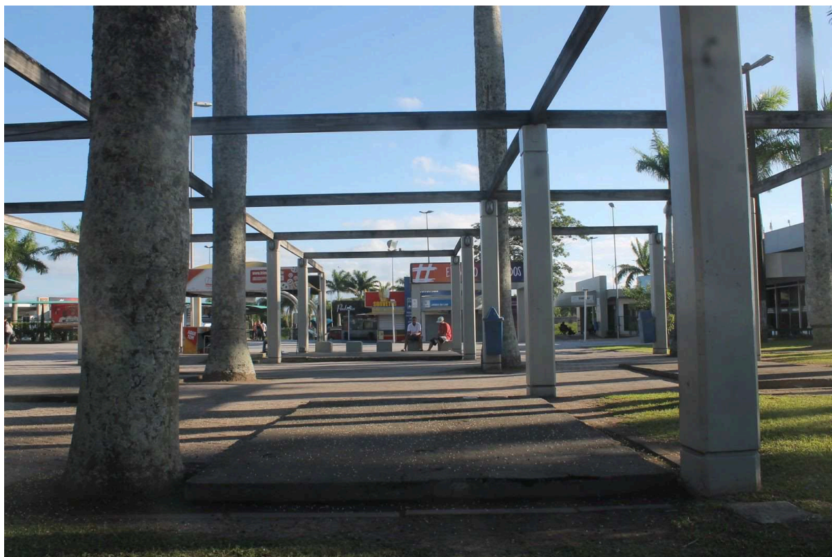
Figura 8: Parte exterior do Terminal de Integração do Centro - Florianópolis - 2019
