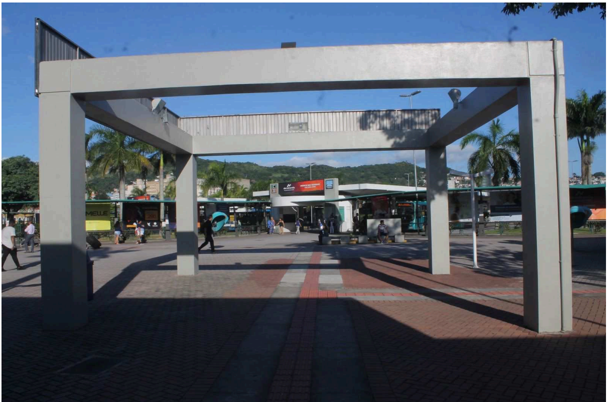
Figura 7: Parte exterior do Terminal de Integração do Centro - Florianópolis - 2019
