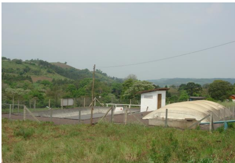
Figura 09 – Biodigestor instalado pelo “Projeto Alto Uruguai” no município de Itapiranga.
