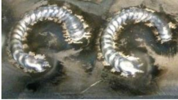
Figura 23: Aparência de cordões considerados apropriados para primeira camada.
