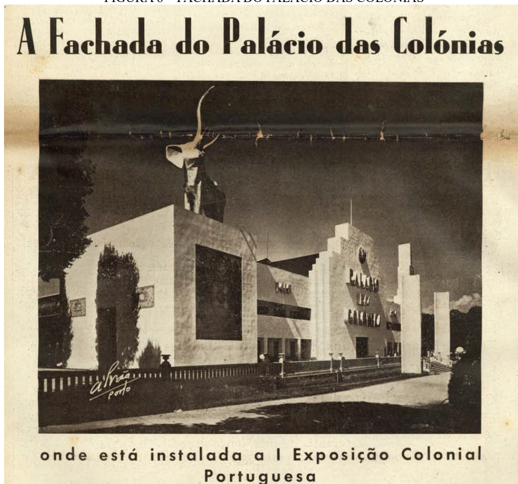
FIGURA 6 – FACHADA DO PALÁCIO DAS COLÔNIAS
