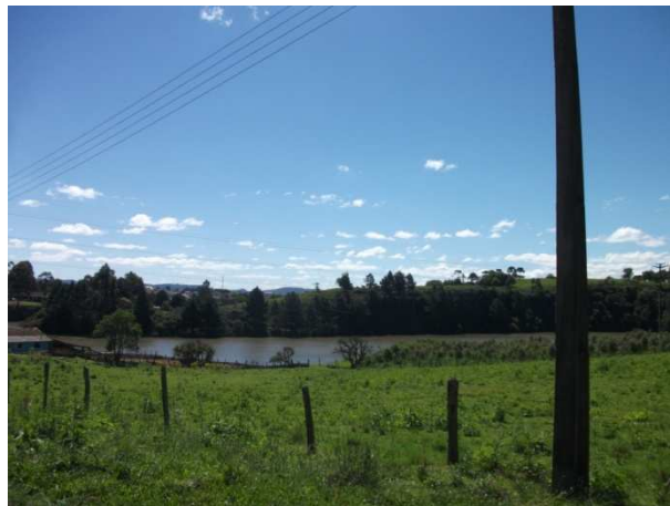
Figura 21: Barragem do Rio Tributo, Município de Correia Pinto – SC
