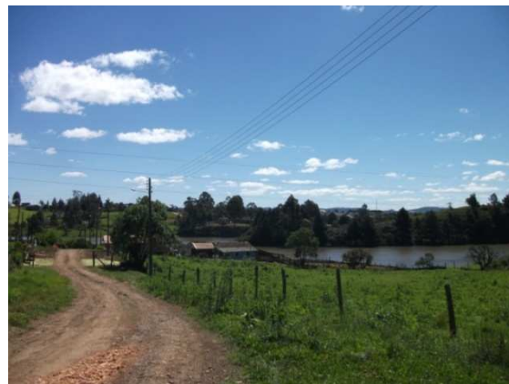
Figura 23: Barragem do Rio tributo, Município de Correia Pinto- SC. Detalhe da ocupação irregular às margens da barragem.
