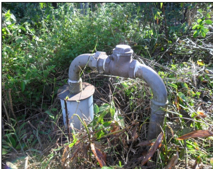
Foto 10: Localização poço profundo N o . 10 – Concórdia/SC.
