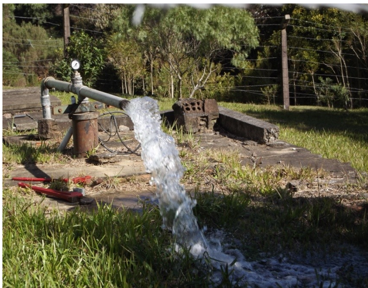
Foto 15: Localização poço profundo N o . 15 – Irani/SC.
