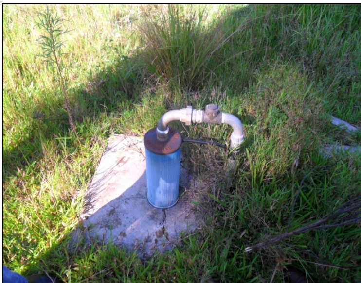
Foto 11: Localização poço profundo N o . 11 – Concórdia/SC.
