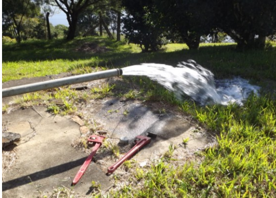
Figura 2: Chaves para abertura e fechamento dos poços
