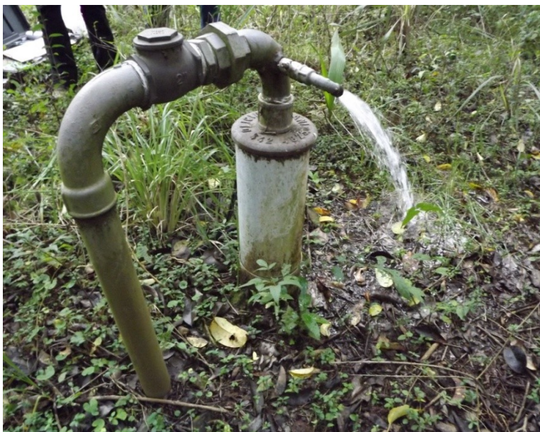
Foto 22: Localização poço profundo N o . 22 – Concórdia/SC
