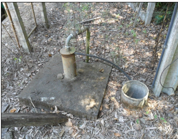
Foto 12: Localização poço profundo N o . 12 – Concórdia/SC.
