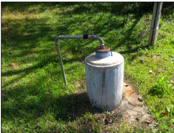
Foto 14: Localização poço profundo N o . 14 – Concórdia/SC.
