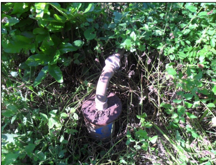
Foto 06: Localização poço profundo N o . 06 – Concórdia/SC.
