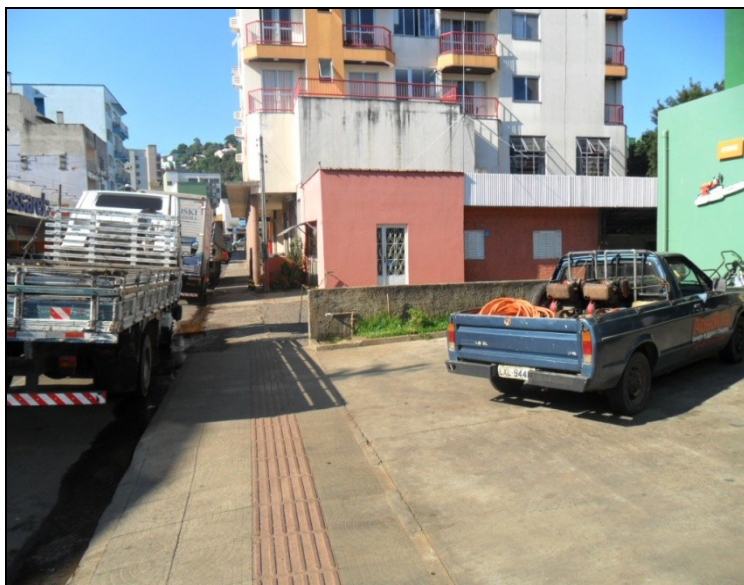
Foto 09: Localização poço profundo N o . 09 – Concórdia/SC.
