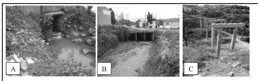
Figura 9: Intervenções no leito do Rio
