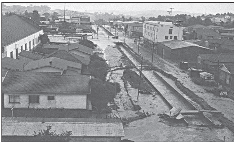
Figura 7: Obra inicial de canalização do Rio Passo dos Índios no centro de Chapecó nos anos setenta. Fonte: Zolet Fotografias.
