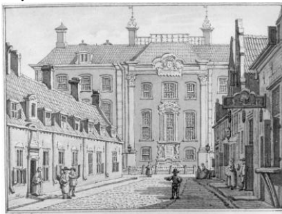
Fig. 3. Foundation house Utrecht, 1789
