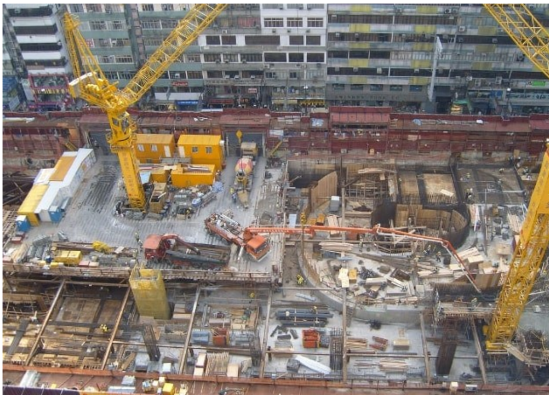
Figura 7 - Canteiro de obras
