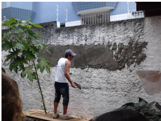
Fotografia 13 – A argamassa é lançada. Fonte: arquivo pessoal.
