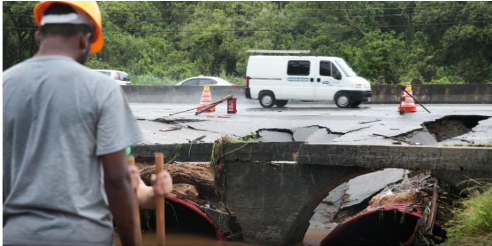
Figura 7 - Trecho na SC-401 que o asfalto cedeu devido as fortes chuvas. Fonte: Torres (2018).
