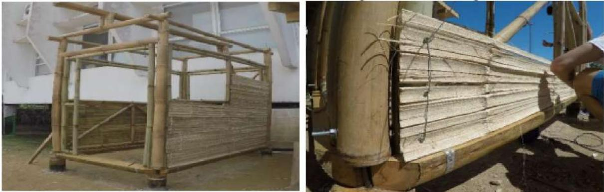
Protótipo em andamento, bambu planificado e fixado com parafusos e arame galvanizado. Fonte: OLIVEIRA, 2018.
