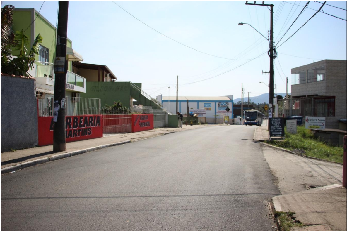
Figura 30 - Rua das Areias - Barreira - Tapera
