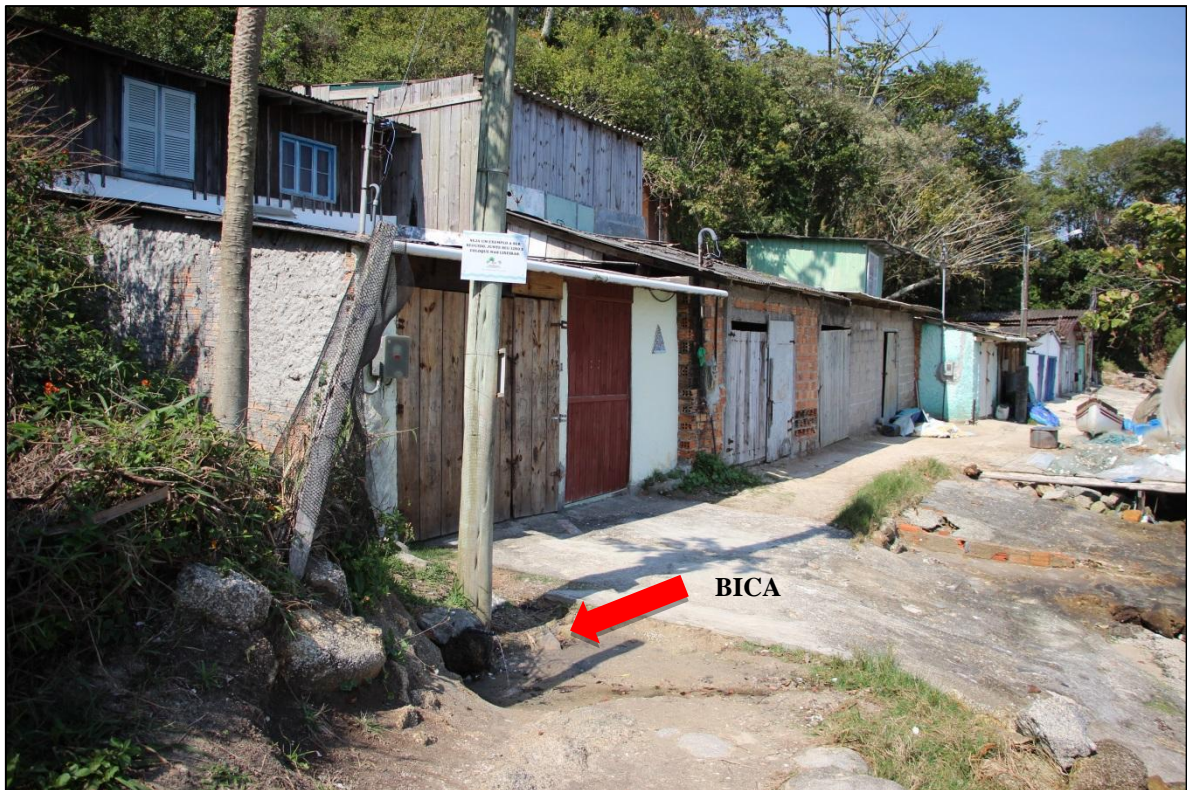
Figura 11 - Local onde se situa a "bica"
