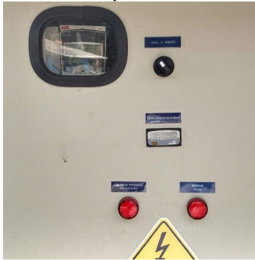
Figura 25: Vista exterior quadro Fortaleza da Barra
