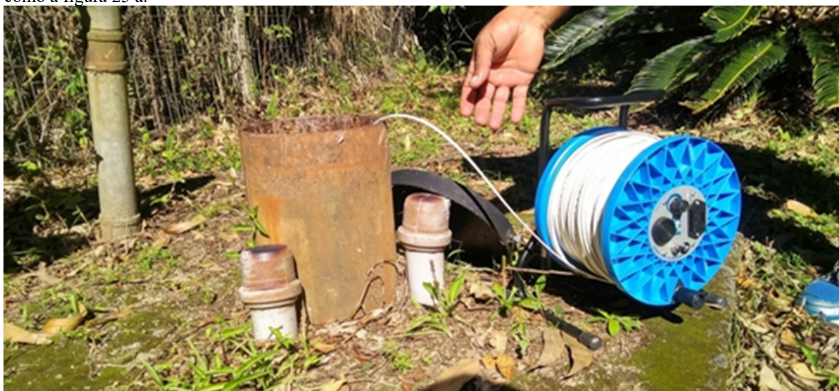
Figura 28: Exemplo de poço desativado (poço Bertoldo) somente a tubulação sem a estrutura externa maior como a figura 25 a.
