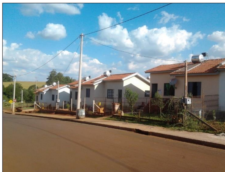
Figura 5: Edificação real construída. Fonte: elaborado pelos autores.
