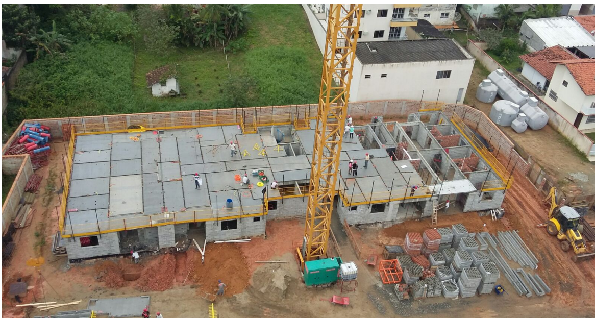
Figura 7: Montagem das lajes pré-fabricadas. Fonte: cedida pela construtora (2018).
