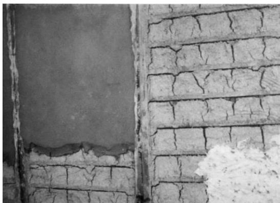
Figura 2: Detalhe barreamento e reboco. Fonte: CEDATE, 1985.
