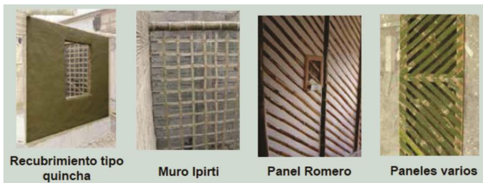
Figura 6: Tipos de painéis de vedação. Fonte: Ubidia, 2015.
