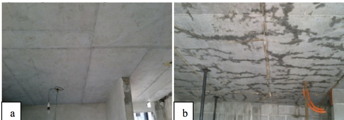
Figura 3: Acabamento da laje nos pavimentos inferiores (a) e acabamento das lajes nos pavimentos superiores (b). Fonte: cedida pela construtora (2014).
