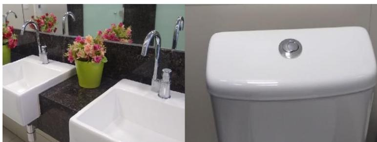
Figura 3: sistema de descarga e torneira com temporizador. Fonte: Acervo das autoras, 2018.
