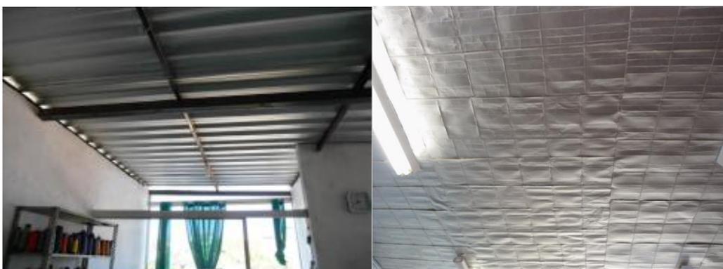
**Figura 3: Telha com revestimento painéis de Tetra Pak. Fonte: Acervo da pesquisa.**
