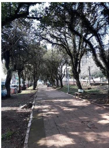
**Figura 1: Passeio de pedestres em condições irregulares e sem piso podotátil, resultando em uma praça não acessível, conforme NBR 9050. Fonte: elaborado pelos autores.**
