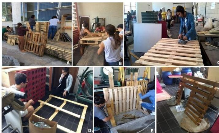
**Figura 2: Processo de execução dos protótipos no canteiro experimental. (A) Seleção dos paletes. (B) Lixamento manual do palete. (C) Lixamento com lixadeira elétrica. (D) Montagem dos paletes. (E) Tratamento com verniz. (F) Palete tratado com óleo queimado.**
