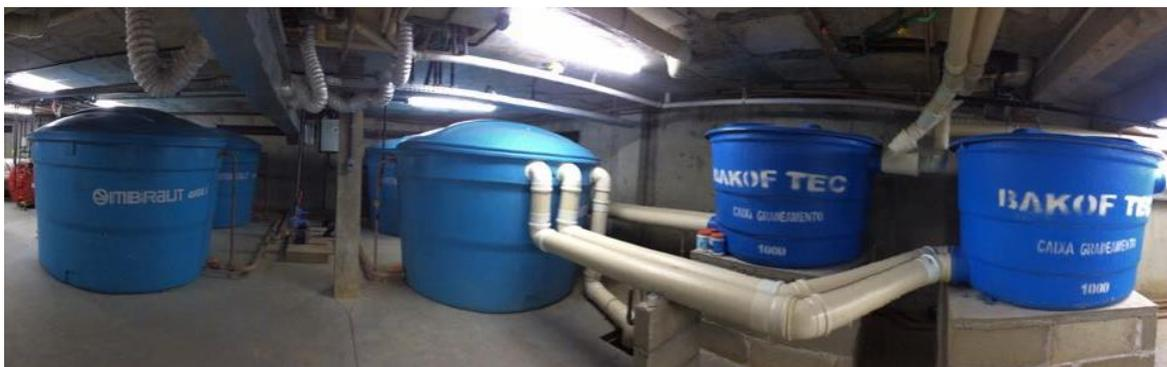
**Figura 1: Cisternas para armazenamento da água coletada. Fonte: elaborado pelos autores (2018).**
