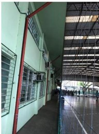
Figura 5: Coletores Verticais. Fonte: Autores, (2018).
