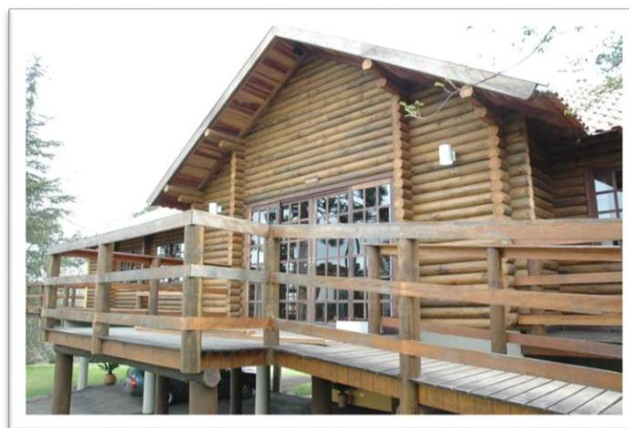
Figura 2: Casa de madeira roliça feita com Eucalipto. Fonte: Monte Verde Eucaliptos (2011)
