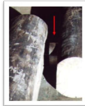
**Figura 8: Peças Unidas por Anel Metálico. Fonte: Teribele (2011).**
