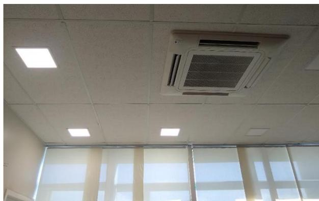
**Figura 5- Ambiente corporativo com destaque para cortina tipo tela, forro fibra mineral, luminária de LED e Evaporador VRF- Fonte: Acervo das autoras**
