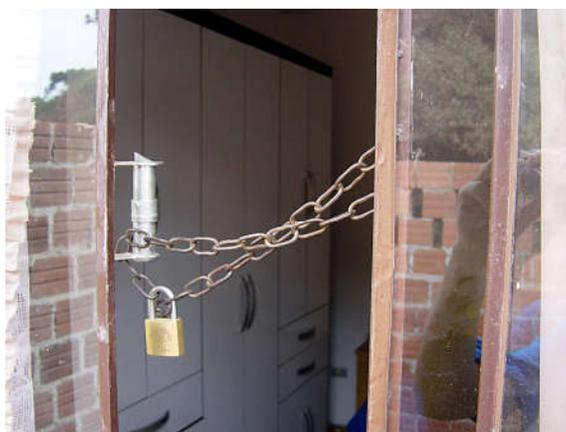
Figura 2: Limitador de abertura da janela. Fonte autores.
