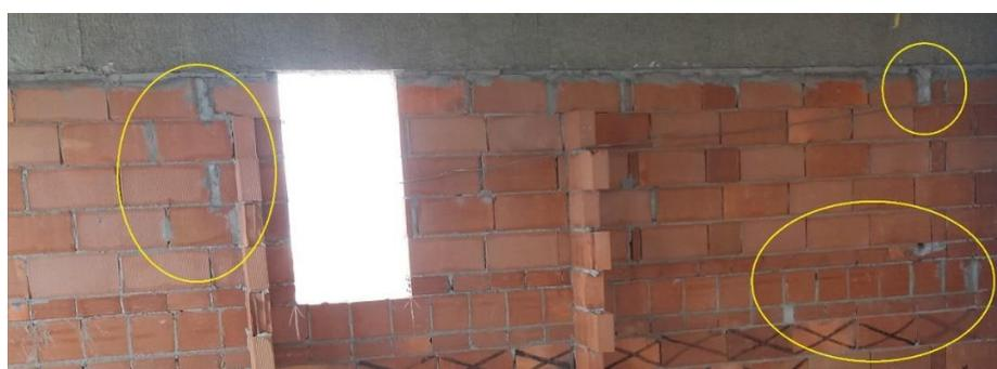
**Figura 4: Sobre-espessura da argamassa de assentamento. Fonte: elaborado pelos autores.**
