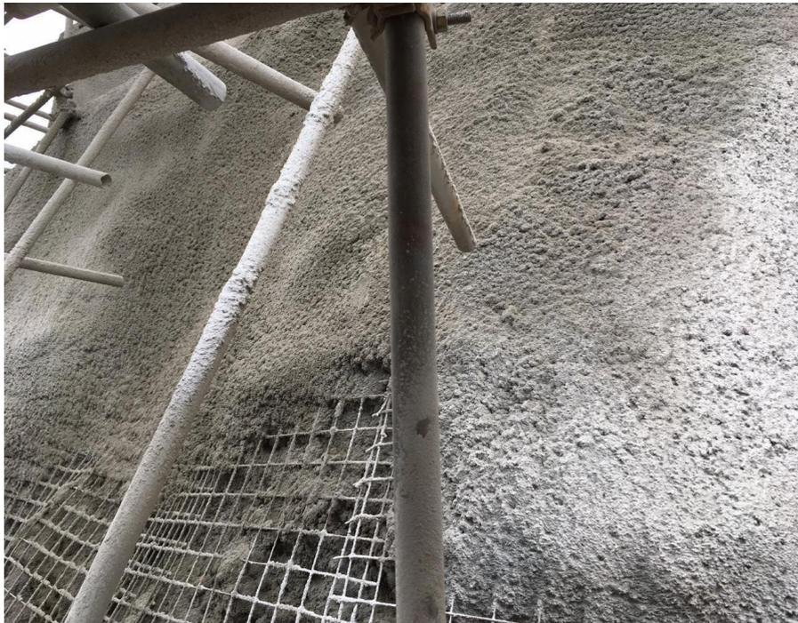
**Figura 9: Execução do projetado. Fonte: elaborado pelos autores.**
