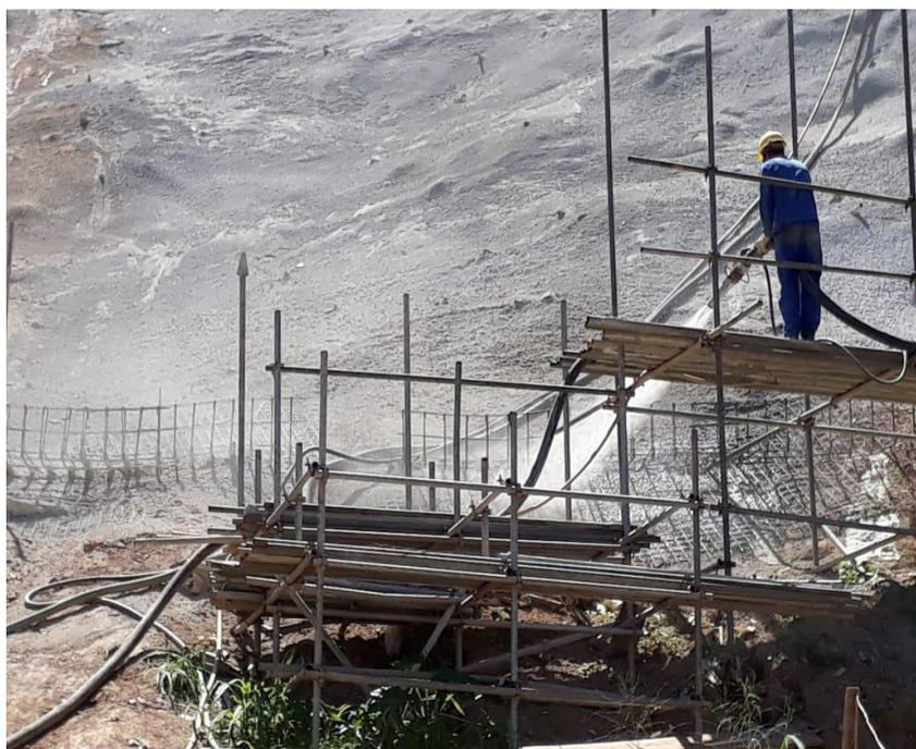
**Figura 3: Concreto sendo projetado. Fonte: elaborado pelos autores.**
