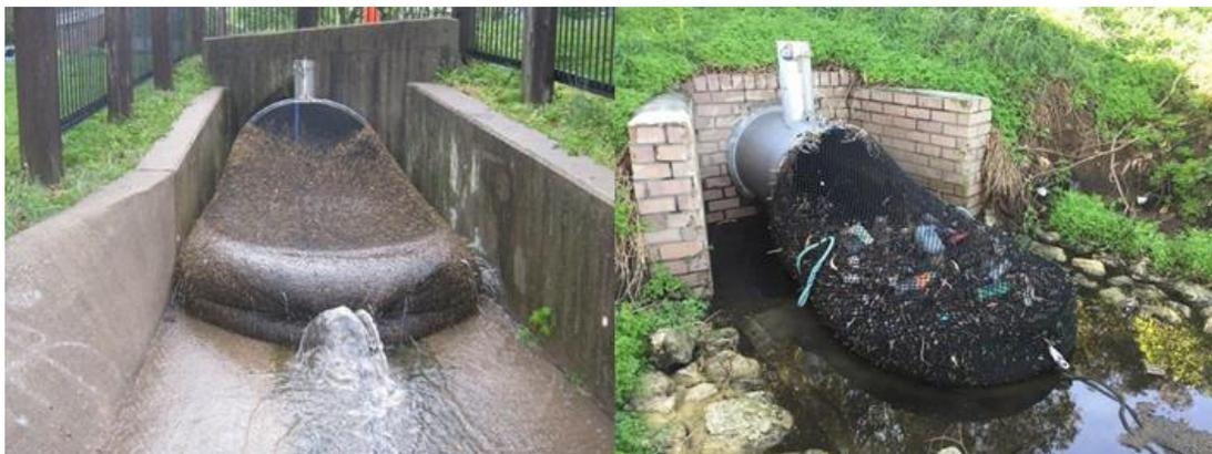
**Figuras 5 e 6. Redes de coleta de sólidos grosseiros utilizadas na cidade de Kwinana na Austrália. Fonte: Storm Water Systems, 2018.**
