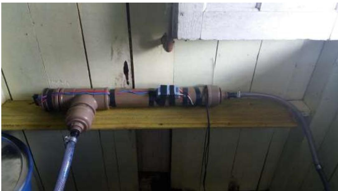
**Figura 5: Filtro UV após a instalação. Elaborado pelos autores.**
