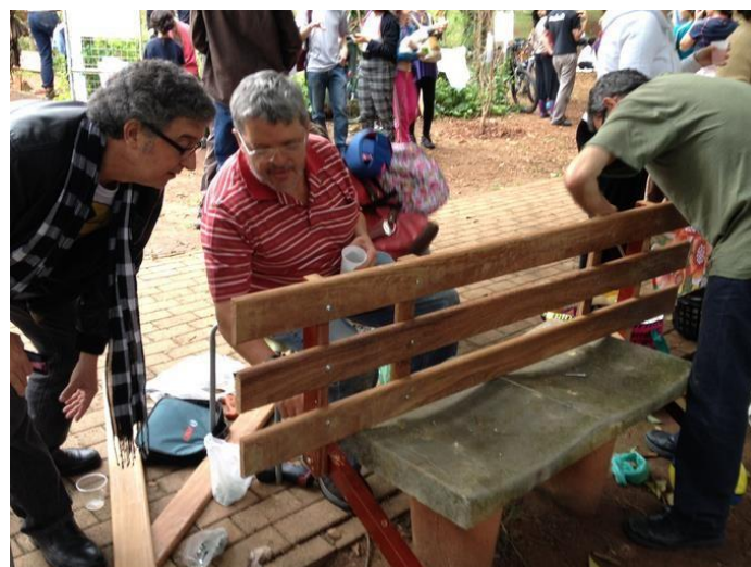
Figura 7: Mutirão realizando melhorias no mobiliário. Fonte: http://movimentoboapraça.com.br/acao-na-praca/melhoria-do-mobiliario-urbano/
