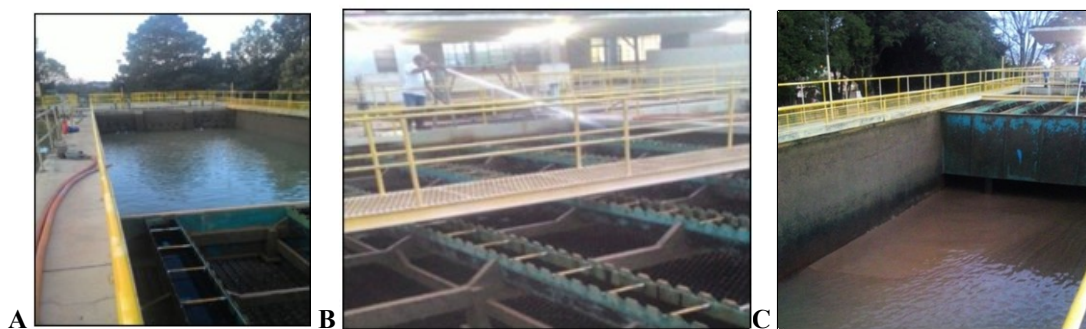
Figura 1: Esvaziamento do decantador (A); o Processo de lavagem do decantador (B); e o Lodo contido no fundo do decantador para retirada da amostra (C). Fonte: elaborado pelos autores, 2016.
