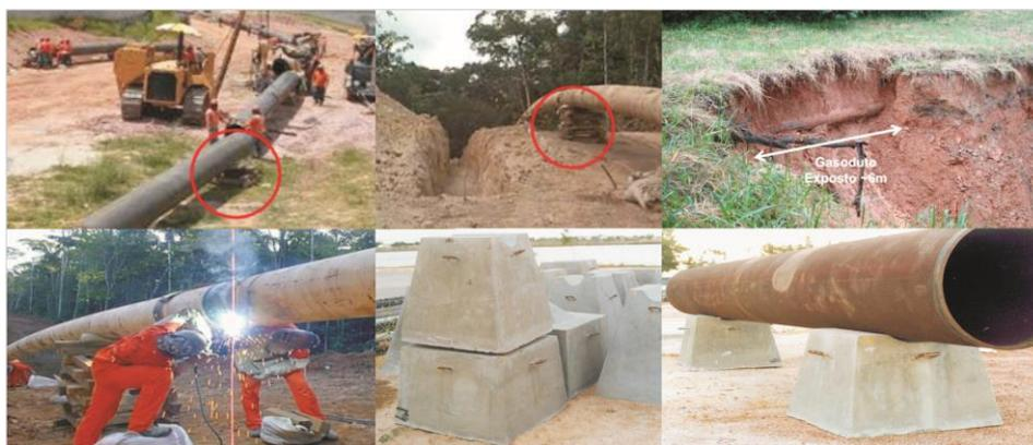
**Figura 4: Imagens de intervenções em dutos terrestres e de poitas de concreto pesadas para suportes de dutos submarinos. Fonte: Elaborado pelos autores.**
