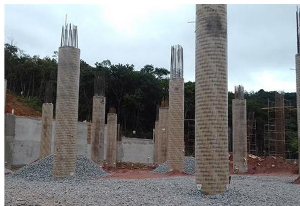
**Figura 9: Estruturas com fôrmas de tubos de papelão. Fonte: Concretubo - <https://goo.gl/mU9aQW>**
