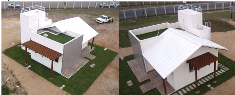
Figura 6 – Vista aérea dos telhados vegetado e com isolamento termoacústico.
