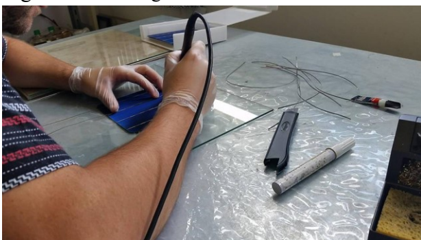
Figura 89 - Soldagem dos condutores nos terminais das células.
