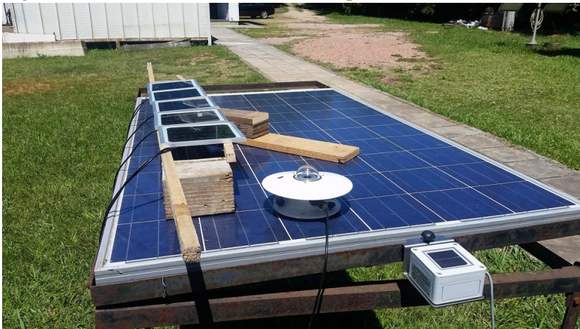
Figura 92 – Células na estrutura metálica para a calibração outdoor das células de referência.
